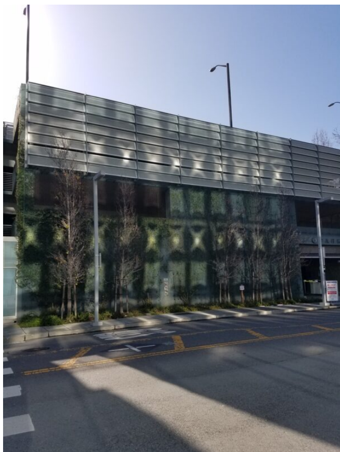
Cercles de lumière pris par F. F. en mars 2022, sur la façade d'un garage d'hôpital à San Francisco, Etats-Unis.
