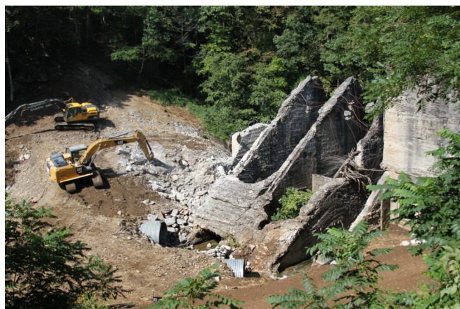
Démolition d'un barrage en cours (Photo : USFWS/Southeast, Wikimedia Commons)
